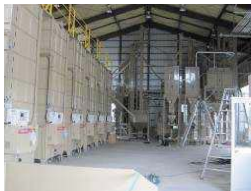
大豆・麦兼用乾燥調製施設の内部
